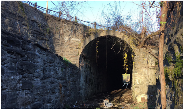
El parquecito se sentará encima del tunel ferroviario histórico y dará acceso por escalera a este antiguo camino para pasar a pie o en bicicleta.
